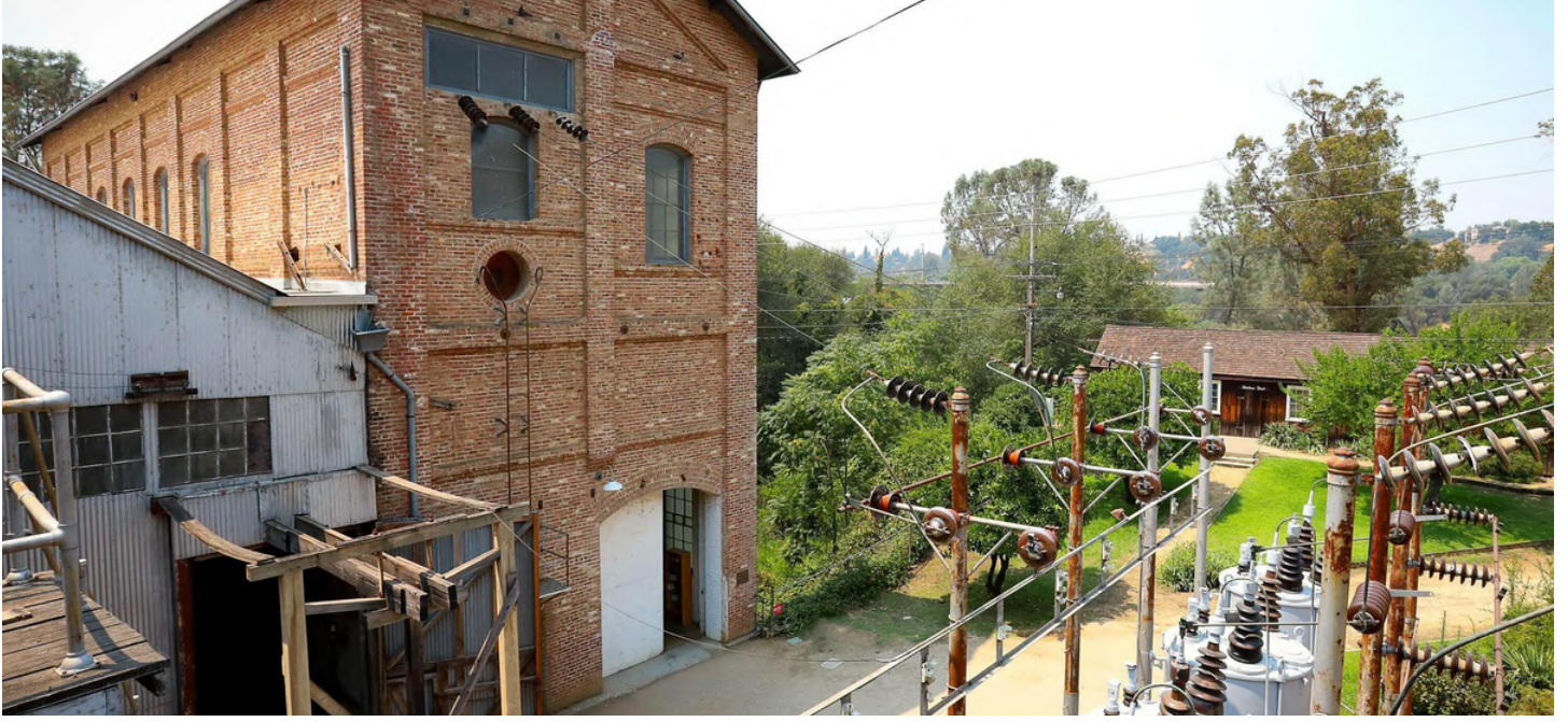
محطة فولسوم في كاليفورنيا أول منشأة ترسل تيارًا مترددًا عالي الجهد عبر خطوط نقل لمسافات طويلة. جلبت الكهرباء إلى ساكرامنتو عبر خط نقل بطول 35 كيلومترًا باستخدام مولدات التيار المتردد المبتكرة حديثًا والطاقة الكهرومائية.
